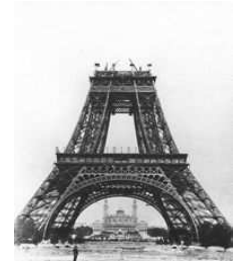
La Tour Eiffel (en construction - 1887)
